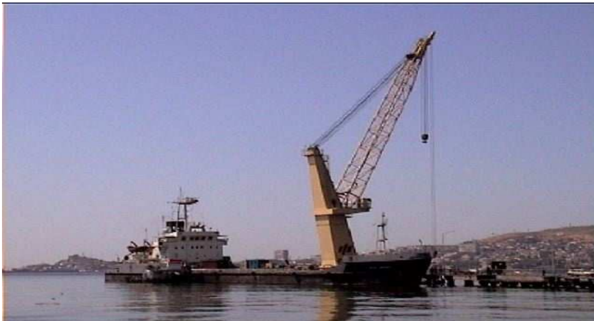
Figure 27 : Maintenance d'une hydrolienne à l'aide d'un bateau
